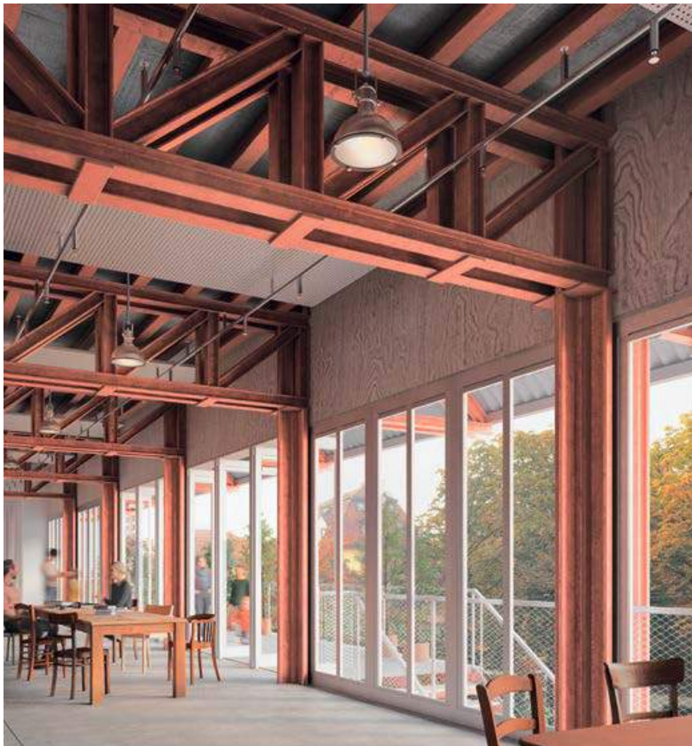
Zwillingsfachwerke in Querrichtung prägen das Stadtgeschoss und bilden eine auskragende Überdachung der Anlieferung.
