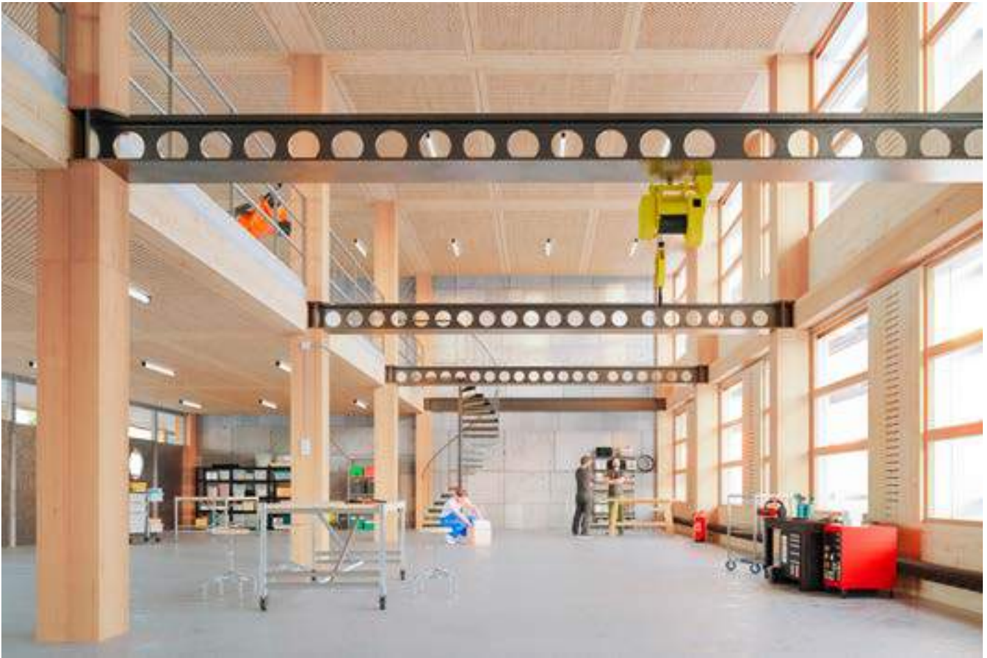
Gelochte ReUse-Stahlträger prägen den Raum und leisten ihren Beitrag an ein lebenszyklusoptimiertes Gebäude.
