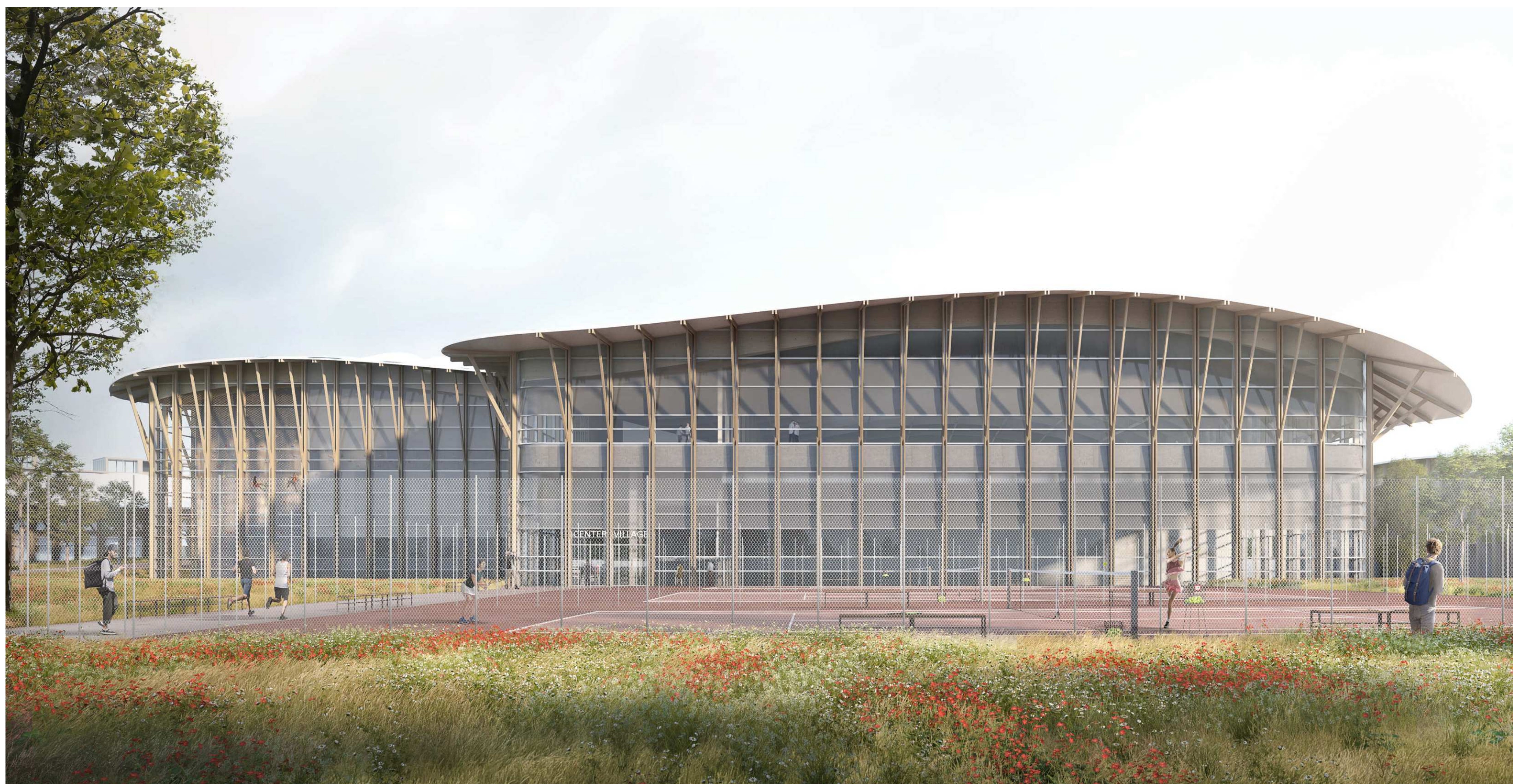
VUE SUR LE BATIMENT 2 DEPUIS LES TERRAINS EXTERIEURS
