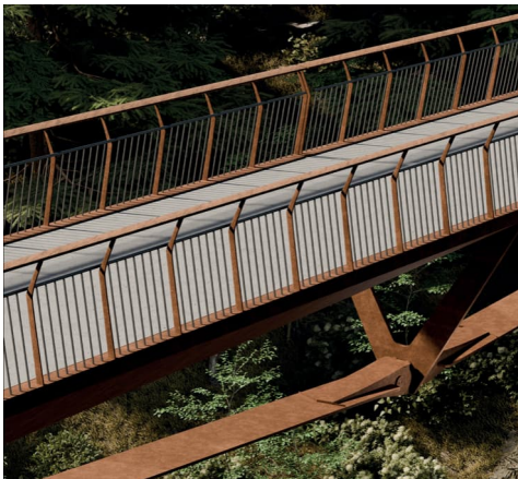
Nahaufnahme von Geländer mit Stahlstaketen und Holzhandlauf
