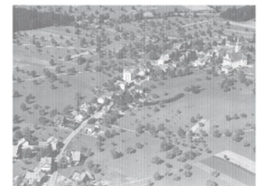
13.06.1952 Luftaufnahme Rain von Werner Frodl
