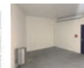
Plateau im Treppenhäuser Seite Leimgrubenweg Bild: soft bloc
