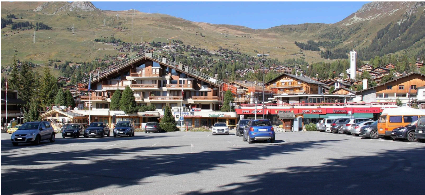
Parking existant à réaménager en place publique.
