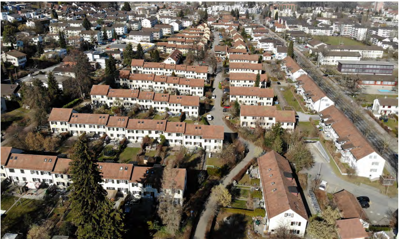
Abb. 4: Siedlung Grabenacker, Blick von Süden (Drohnenaufnahme, März 2019, Eckhaus AG)
