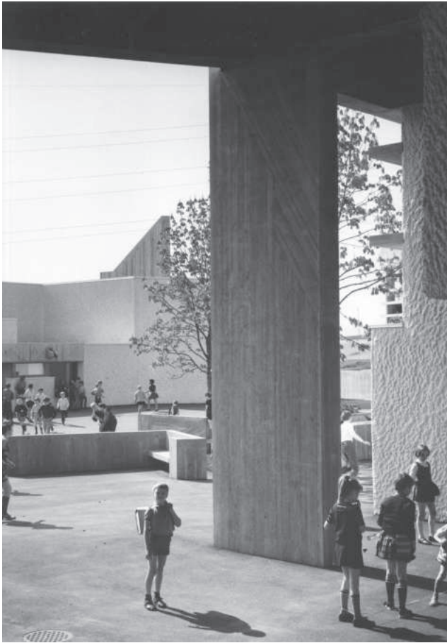
Pausendach, Blick auf Klassentrakt West, 1968, Foto: Fritz Maurer, BAZ
