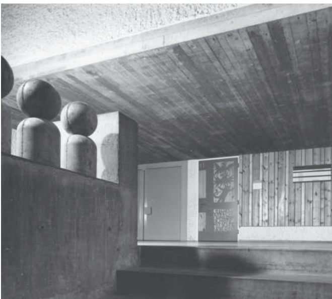
Erschliessungshalle Klassentrakt West, Blick auf Eingang, 1971, Foto: BAZ
