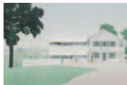
Vue depuis le sud, le pôle parascolaire et restauration scolaire. L'extension prolonge la structure existante au sud-ouest de la bâtisse.
