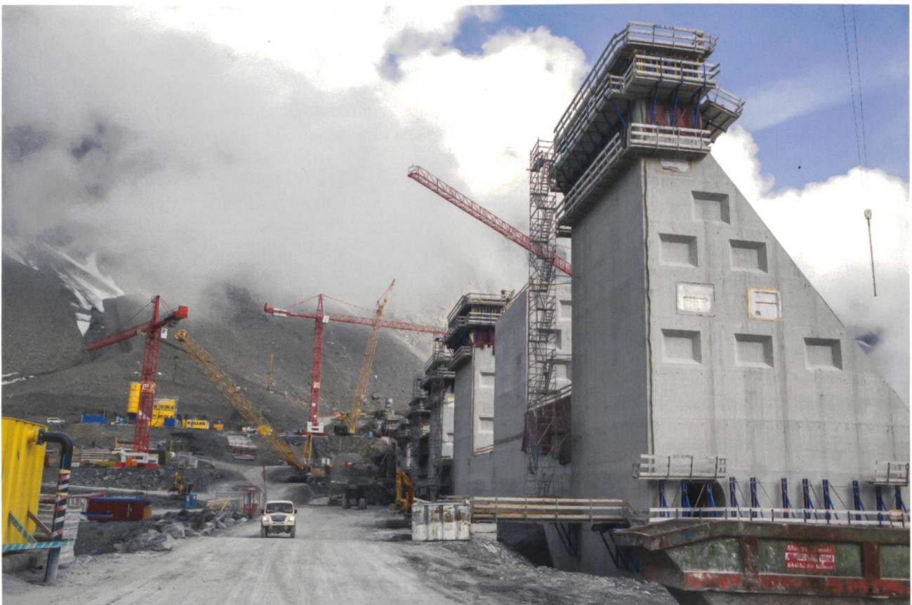
**Bau der Mauer mit Kletterschalungen im Pilgerschrittverfahren.** Die Aussparungen zur Verzahnung der einzelnen Blöcke und der Kontrollgang unten links sind gut erkennbar. Der Block ohne Kletterschalung musste aufgrund ungenügender Betonqualität teilweise rückgebaut und neu erstellt werden.
