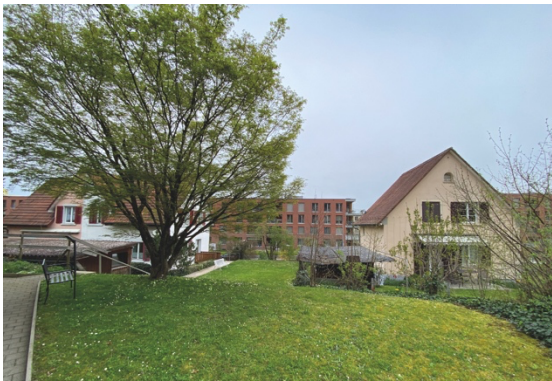
Rückfassaden Dachlerstrasse 71, 73 und 75
