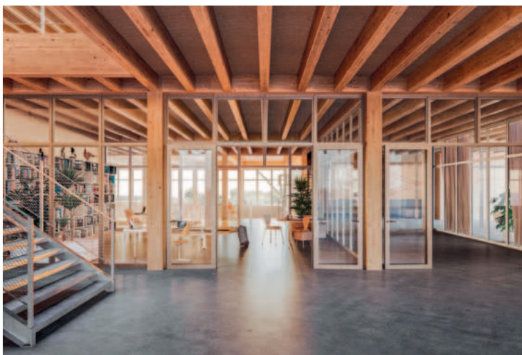
Ein offenes, flexibles Holztragwerk strukturiert die Schulräume.
