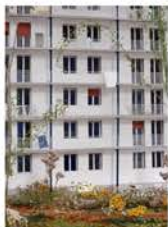
Vue extérieure, les balcons prolongent l'espace de vie
