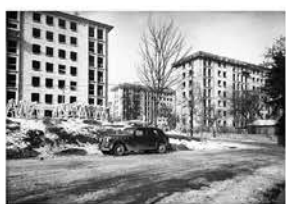
Photo de chantier - Travaux de Miléant et Borges
