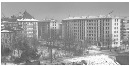
Les ornements d'origine sur les cages d'escalier sont identifiables Photographies d'archive ©BGE, Centre d'Iconographie Genevoise
