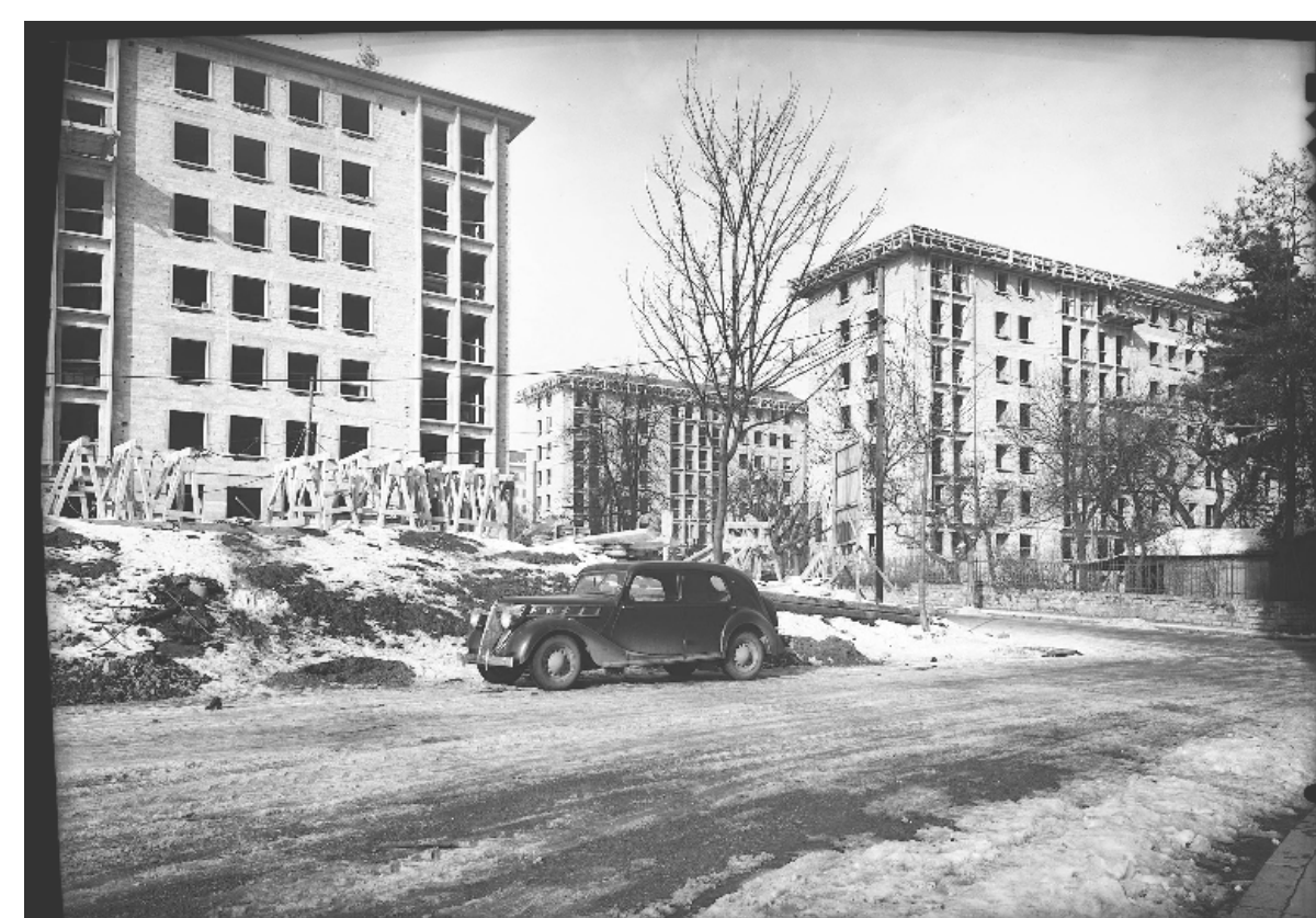
Genève, Rue de Miléant - 1949. Immeubles De la Rue de Miléant en construction. L'image montre les éléments construits de la façade et de la toiture: du béton coulé sur place pour le rez-de-chaussée, de la brique pleine à l'étage, de la charpente en bois pour le toit.
