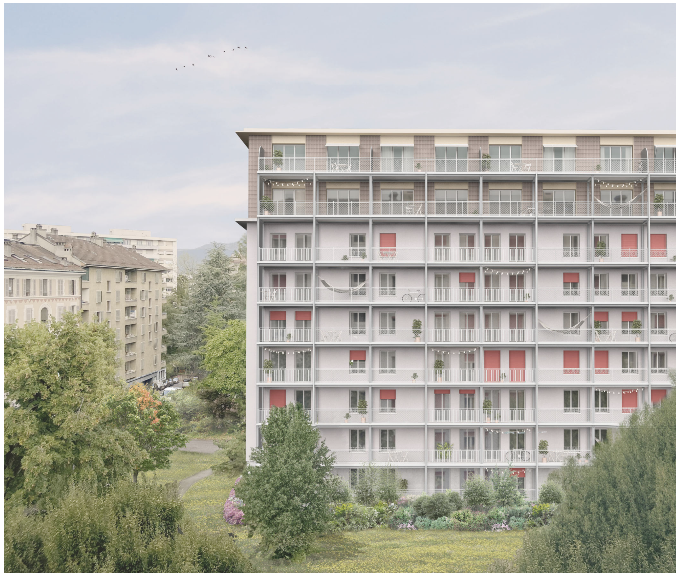
Vue extérieure depuis la fenêtre du bloc B.
