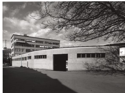
RWB-Gebäude, Bestand Strassenseite Güterstrasse
