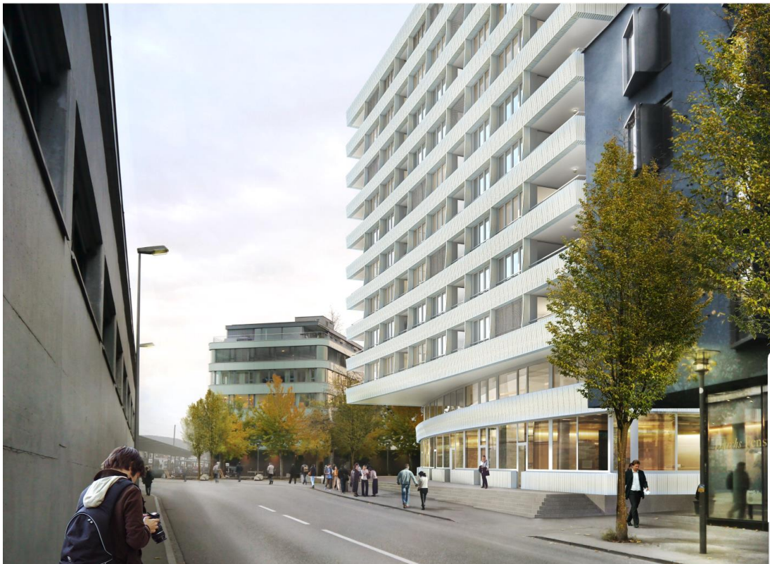
Mitte rechts: Müllerbräu-Areal Haus B von Studio Gugger – links RWB-Werkstattflügel, Mitte Langhaus, rechts Blue City-Hotel
