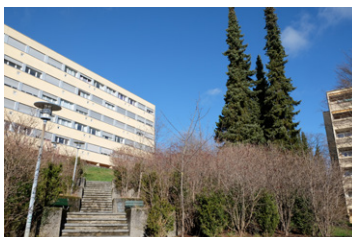
Certains arbres accompagnent la verticalité des immeubles
