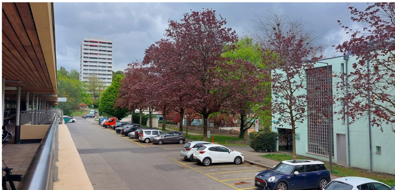
L'allée centrale du quartier. Sur la droite de l'image est visible le bâtiment de FO qui fera l'objet d'une transformation lourde (programme EMS). Sur la gauche le bâtiment au rez duquel sera développé l'APEMS.
