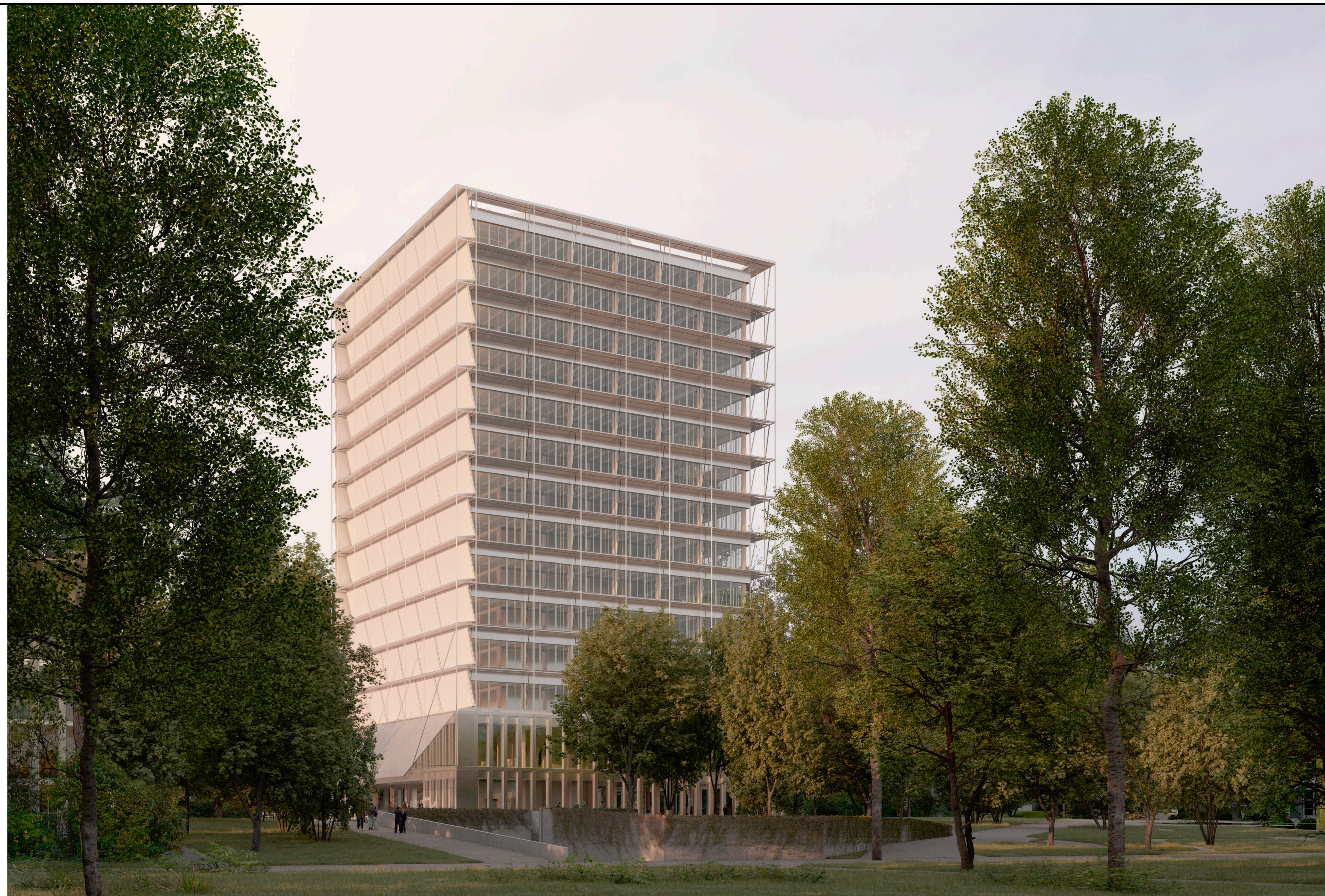
Der Turm spielt viel an Grünraum frei und verwebt sich durch die Auflösung der äusseren Schicht mit den bestehenden und neuen Bäumen des Parks. In seiner Präsenz wirkt er als solitärer Baustein innerhalb einer Campustypologie. Er ragt aus dem Park und verbindet sich mit ihm.
