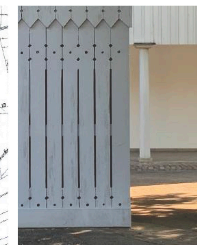
Hölzerne Säule und Fassadentäfer Villa Schoier
