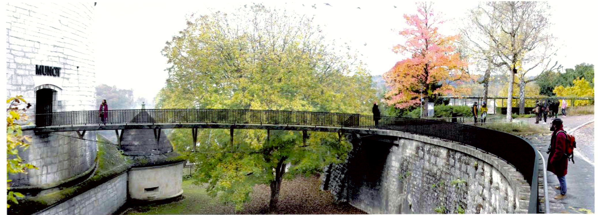
Brücke über den Hirschgraben: Das Geländer und die Fahrbahn der Brücke gehen nahtlos in das der Stützmauer über
