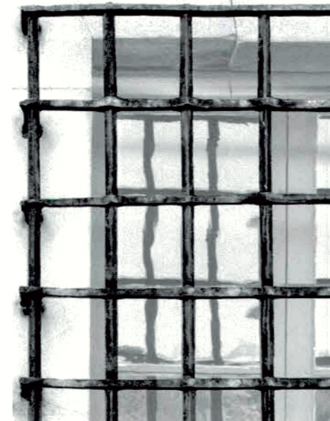
Geschmiedete Gitter kommen bei alten Burgen und Schlössern häufig vor. Eine Referenz für das neue Geländer.
