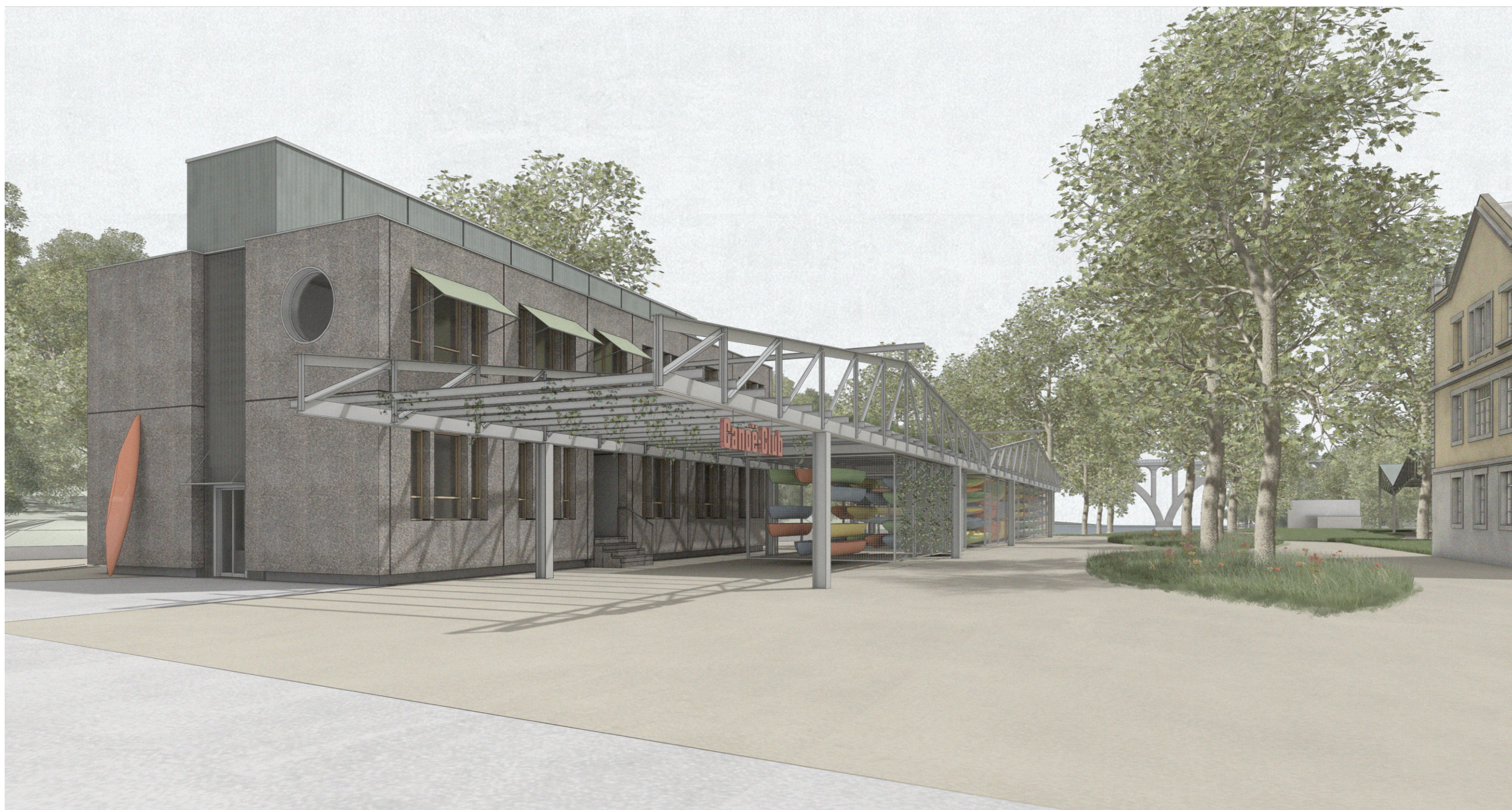
Vue depuis l'Avenue de la Jonction
