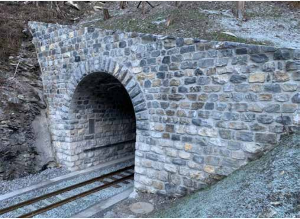
Mistaltunnel, Bild aus PGV Bericht Toutaltunnel
