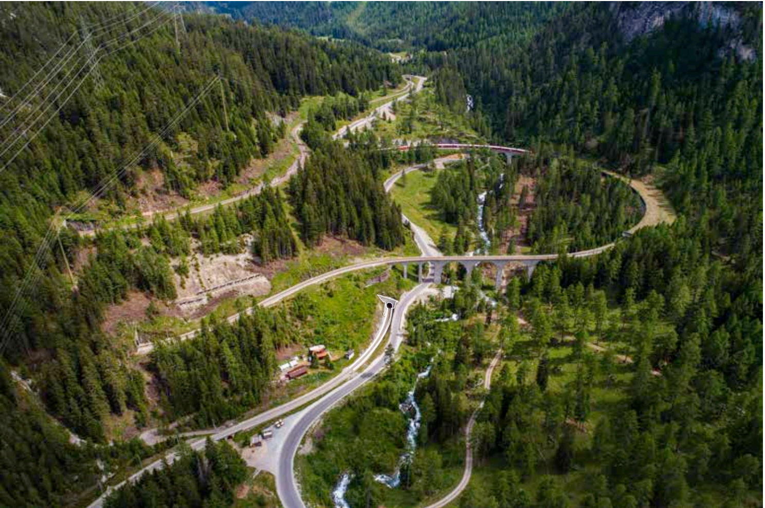
Aus der Vogelperspektive kann der Eingriff kaum wahrgenommen werden. Eingeweihte werden jedoch die aus dem Tunnel tretenden Betonkanäle erkennen, welche soweit hinausreichen bis sie die Portalszene verlassen haben. Die hellere Farbe des gesäuberten Steins wird genauso wie bei der dahinterliegenden Brücke für die Dauer einer Generation erkennbar sein, mit der Zeit aber unbemerkt wieder verschwinden.
