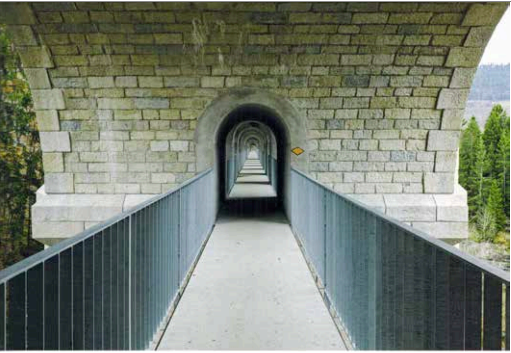
Viaduc du Day
