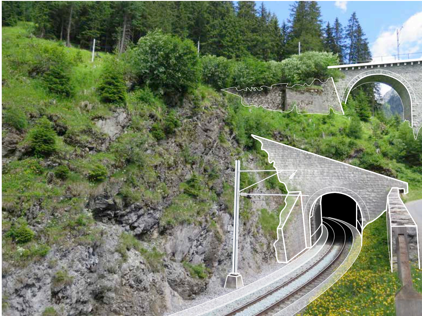
Sichtbarmachung Tunnelausbau: Betonkanal, Beleuchtung Das Ende des kurzen Tunnels kann im Schatten erahnt werden
