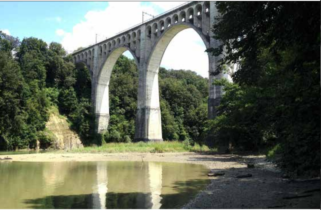
Viaduc de Grandfey
