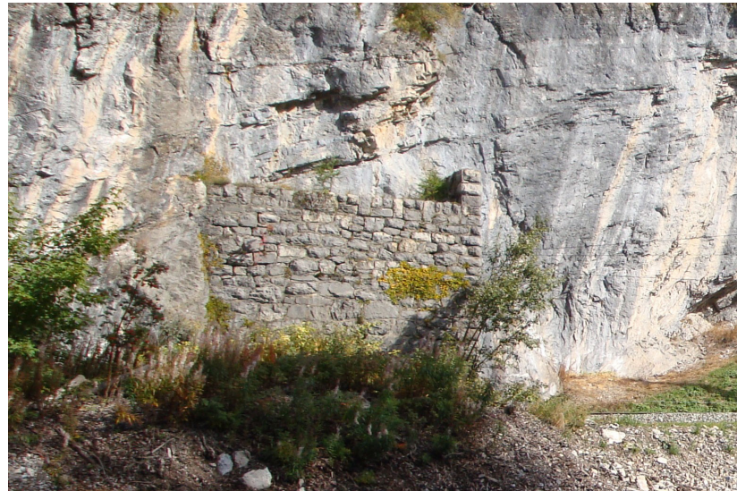
Touatunnel (links) Portal Muot (oben) und Preda (unten)
