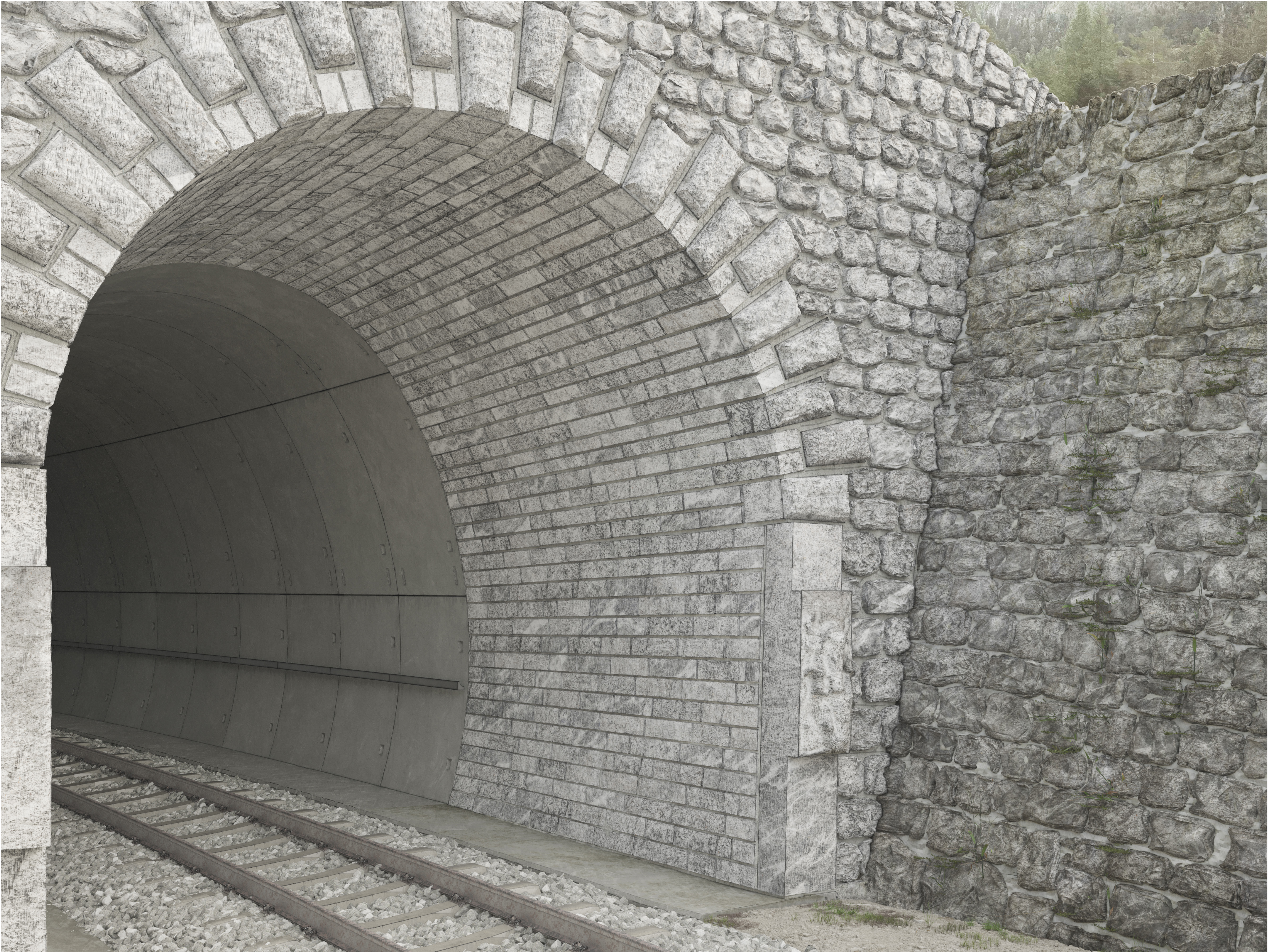
Portal Toua Tunnel Seite Muot: Übergang formwilde Steine zu gesägten/gespaltene Steine mittels Reuse-Kranzsteinen und neuen, bildhauerisch bearbeiteten Stelen/Wandpilastern
