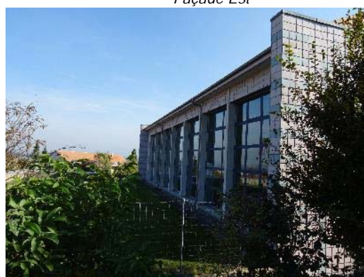
Vitrage salle de gym
