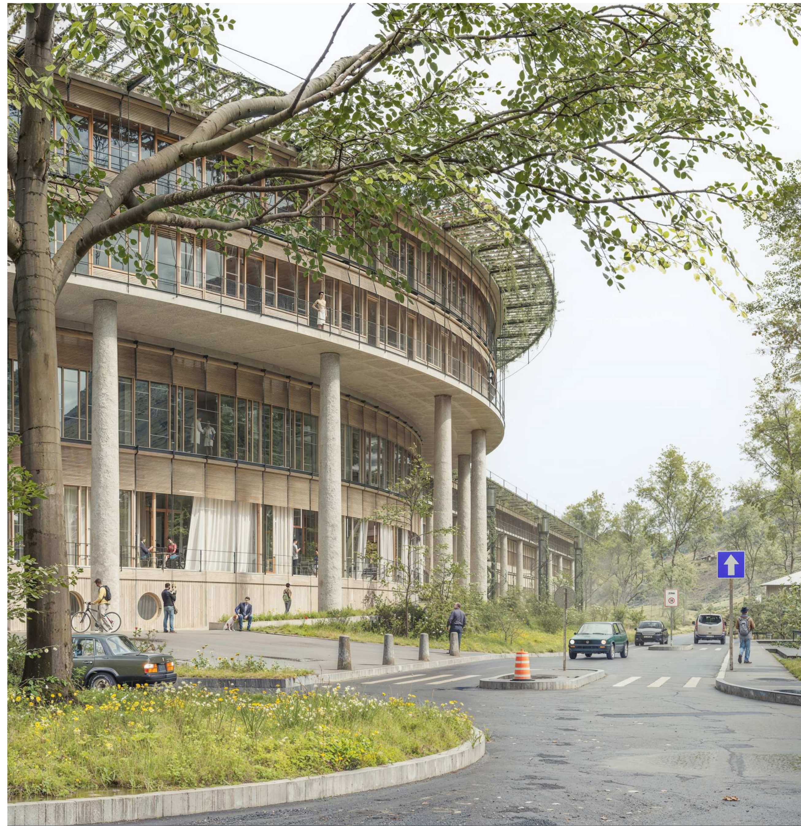
La piazza di fronte all'ospedale mette in scena la rampa d'ingresso che circola il giardino d'inverno del ristorante „Selva“.
