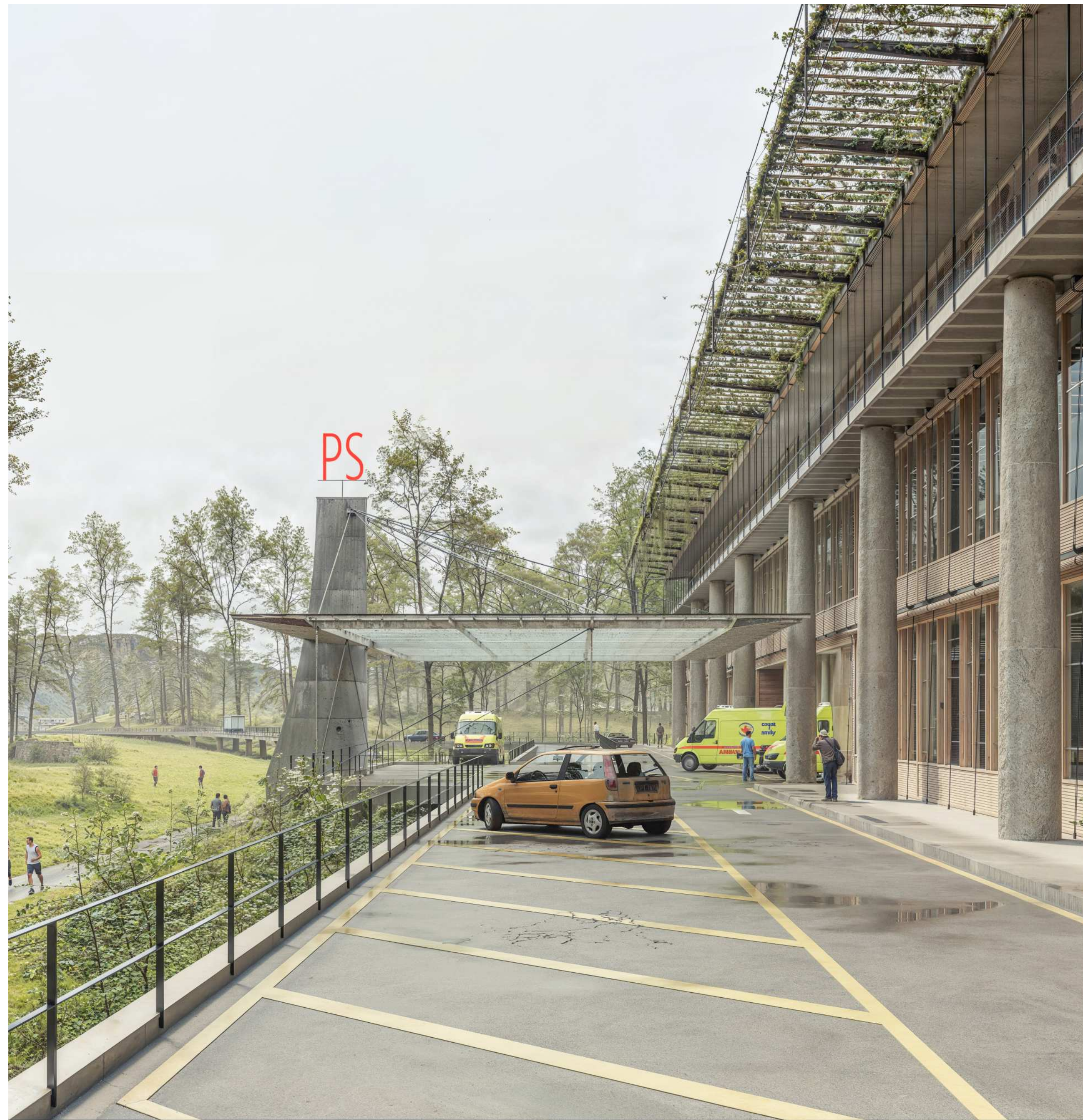
La terrazza per il pronto soccorso anche ingloba le rampe che portano giù all'atrio logistico e il parking per creare un sistema efficace e compatto. Tutti auto, camion e ambulanze escono attraverso il viadotto in fondo.
