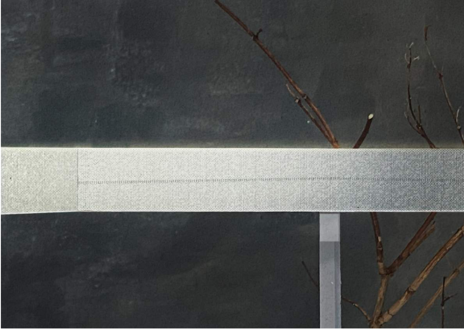
La dimensione relativamente ridotta dei fori viene percepita come gradiente d'ombra. Di notte grazie alla retroilluminazione delle travi il ponte si illumina in maniera discontinua e opalescente.
