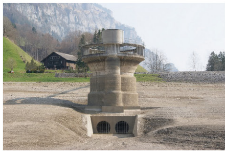
Einlaufbereich des Grundablasses. Die Öffnungen haben einen Durchmesser von 2.80 m.
