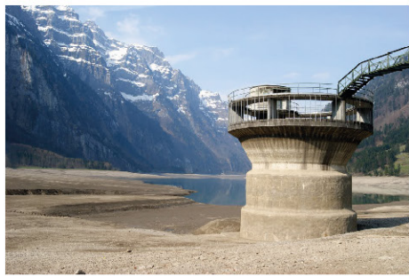
Abgesenkter Stausee mit sichtbarem Überlaufurm. Die Krone hat einen Durchmesser von 18 m.
