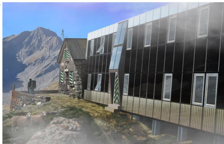
Le nouveau bâtiment vient s'ajouter comme l'ancienne cabane. La façade sud est revêtue de panneaux solaires thermiques et photovoltaïques, et des panneaux métalliques de parement complètent la composition.
