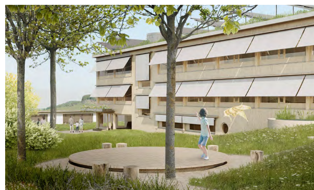
Ausdruck der Erweiterung Die nach Norden ausgerichtete Struktur ist einfach umhüllt, und das gleiche Modul aus Fenstern und Ausstellstore setzt sich über dem Eingang fort. Die Nordostfassade enthält in den oberen beiden Etagen ein zentrales Fenster für die neuen Gruppenräume.
