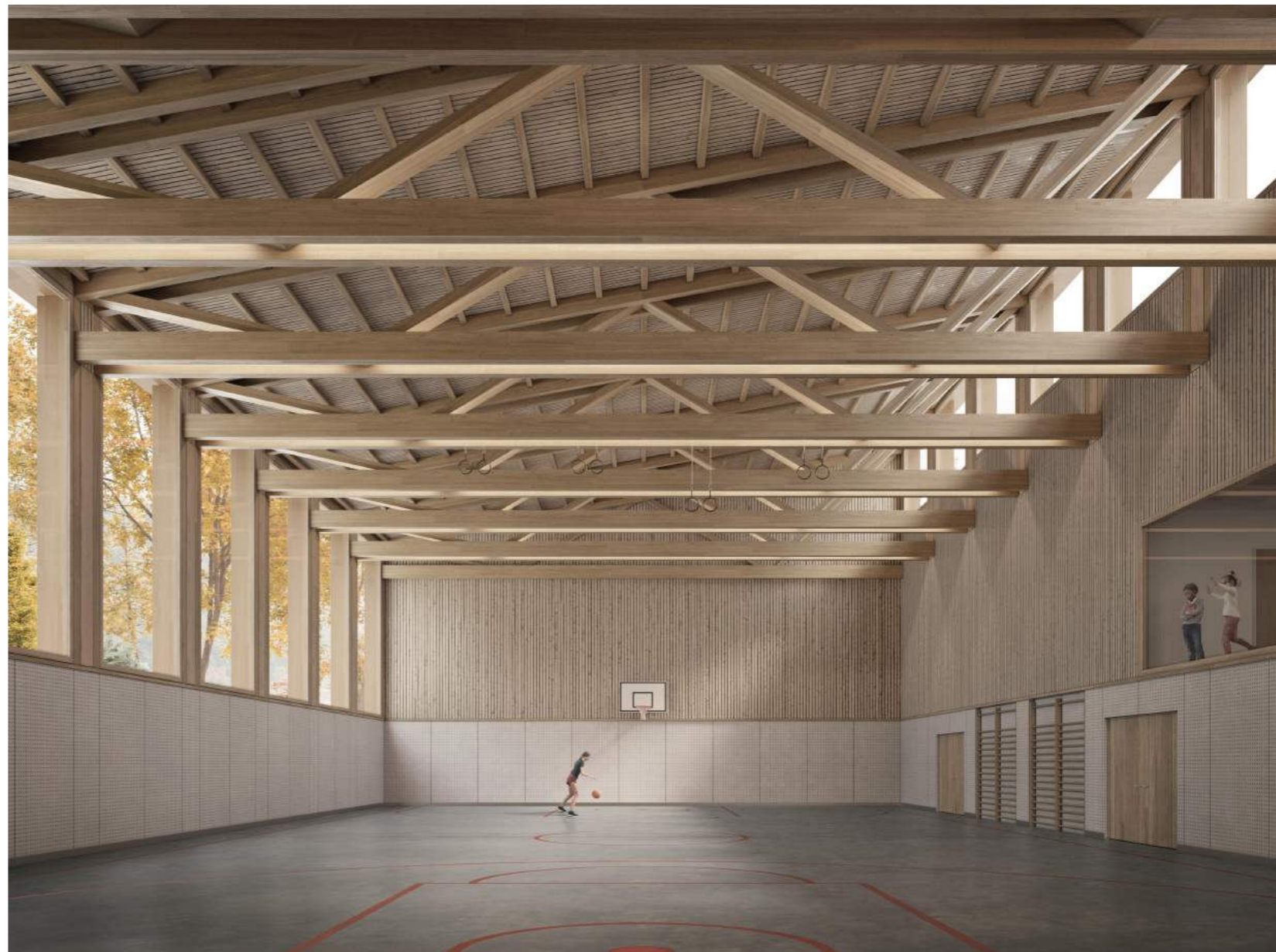
Charakterdächer, filigrane Stützen, viel Licht - das Holzhaus evolviert mit seiner leichten Erscheinung etwas Heiteres. Schlanke Fachwerkträger, welche den Raum zum Licht hin öffnen. Zwischen den Trägern liegen die Leuchten, wie auch die Installationen für die Turngeräte.
