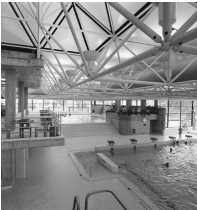
Mehrgeschossige Schwimmhalle, Foto: Peter Grünert, Datum unbekannt
