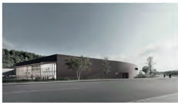
VUE SUR L'ANGLE EST DEPUIS LA RUE CORBAROCHÉ
