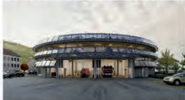
Vue vers la caserne depuis la zone de manœuvre
