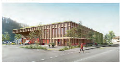
Vue sur l'entrée de la caserne depuis la Route de Corbaroche
