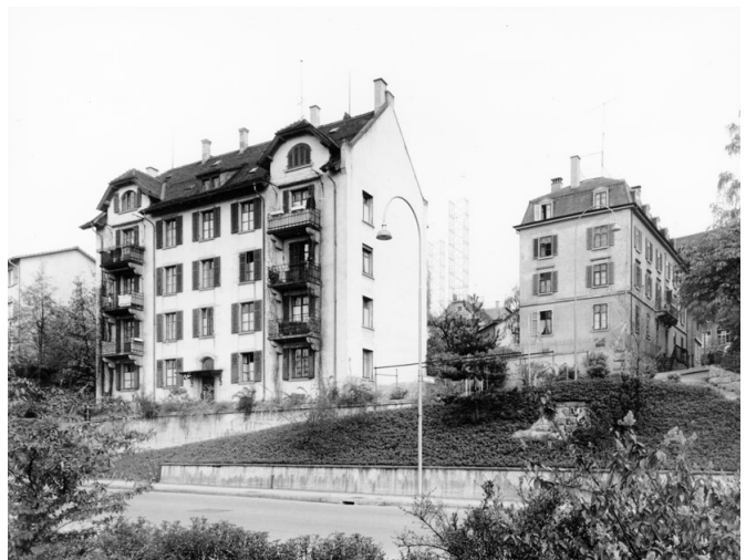
Fotografie mit Bestandesbau (links) und inzwischen abgerissenem Gebäude (rechts) von 1962, Baugeschichtliches Archiv der Stadt Zürich
