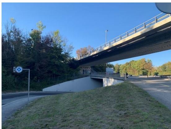
20. Passage sous la route de Lausanne
