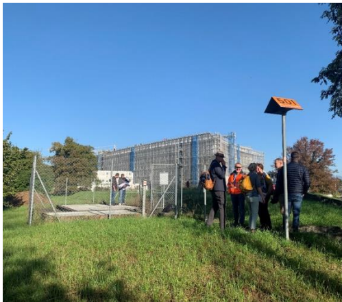
10. Poste de sectionnement GazNat
