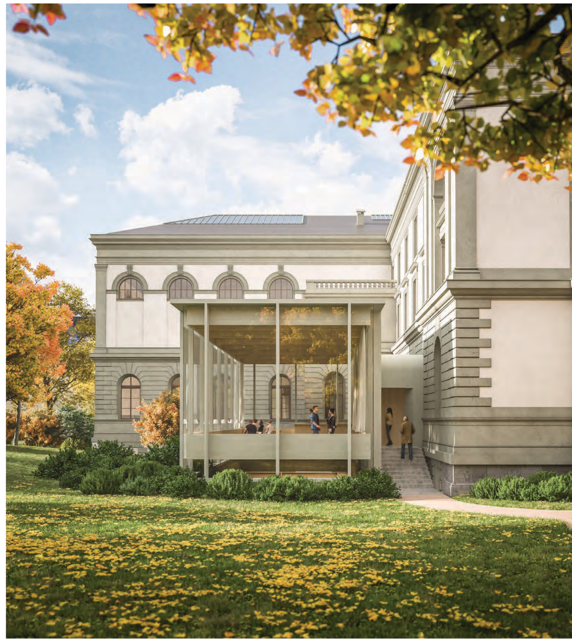
pavillon nord - vue nord
