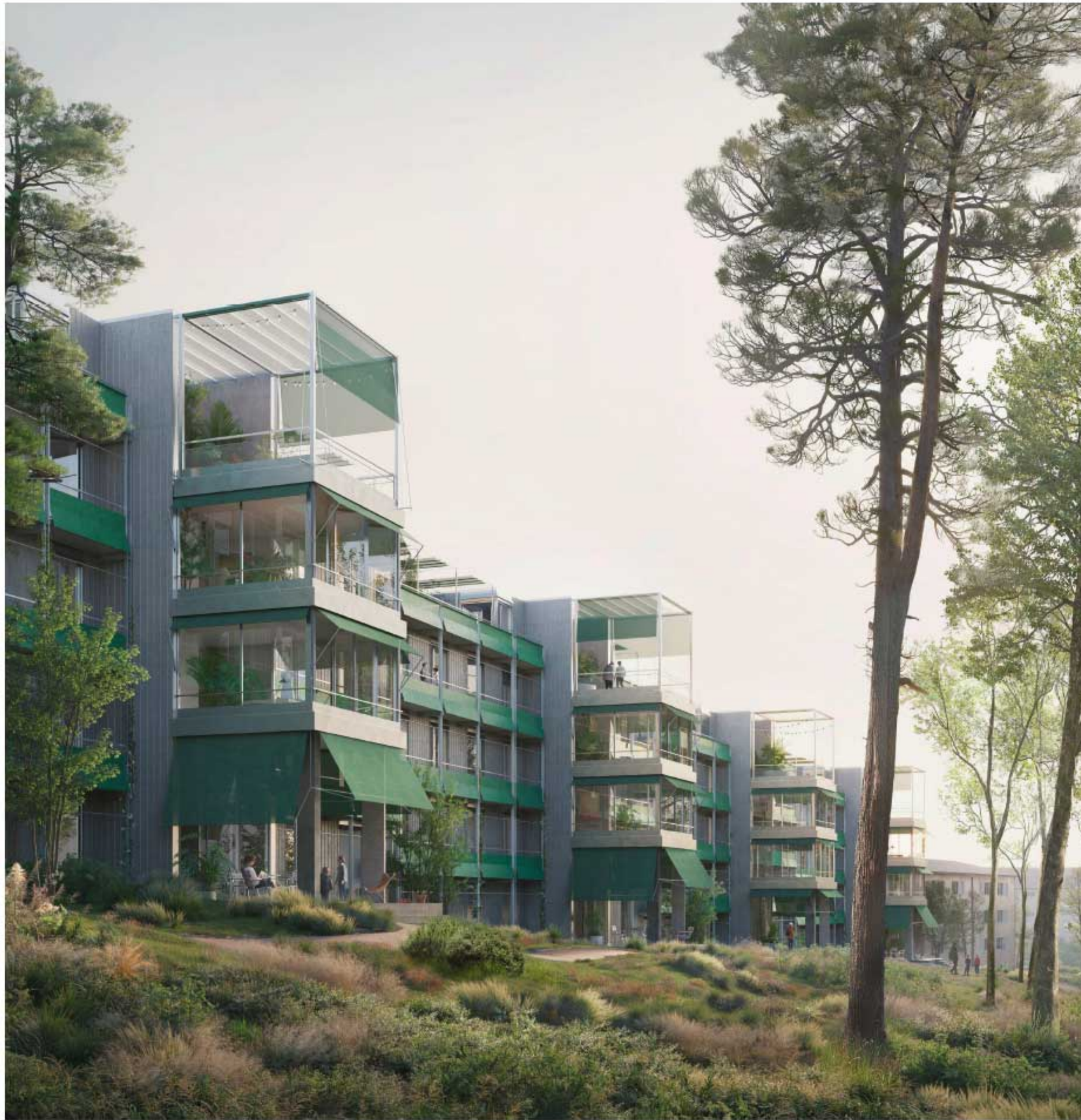
Die metallischen Profile der durchgehenden Balkenbrüstung an den Nordostfassaden dienen gleichzeitig als Rückläufe für Pflanzen, an den Südostfassaden werden diese auch vorgegeben. Die Erkerterme gliedern die Gartenhöhe zueinander und geben den Maßstab für eine gartenstädtische Massstäblichkeit.
