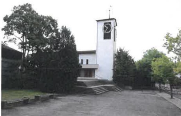
Etzelstrasse 20, Ansicht von Westen, 31.07.2014.
