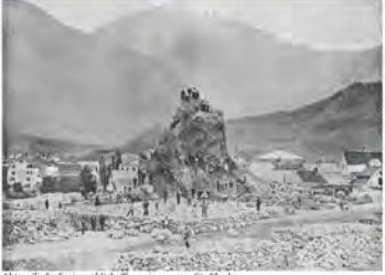
Abtrag Tschudirain und Schaffung eines neuen Stadtbodens
