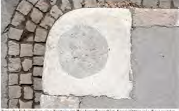
Typische Eckkanten einer Trottoirs im Wiederaufbaubereich. Spezialstein wie diese werden aufgenommen, weil schon benutzt und weiterverwendet
