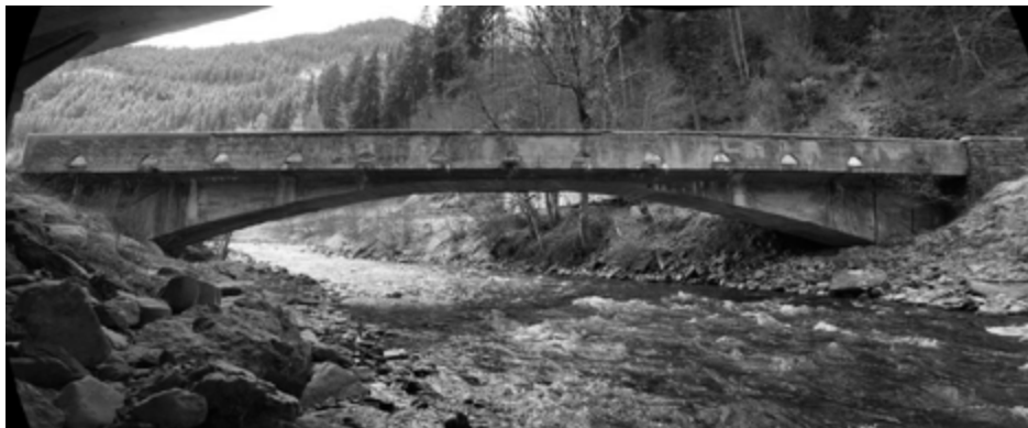
Die historische Landquartbrücke Dalvazza aus dem Jahr 1930 (Blickrichtung flussaufwärts).
