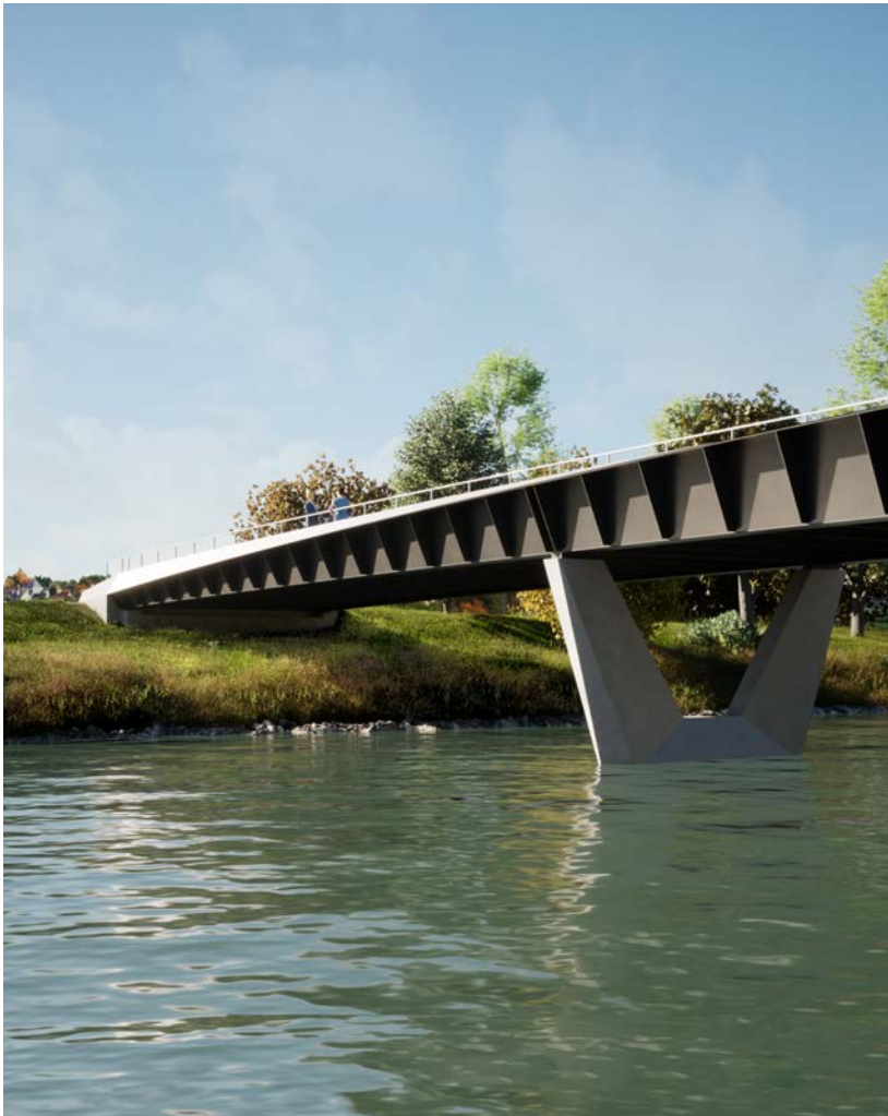
Blick zum westlichen Widerlager
