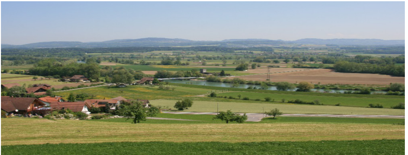
Abbildung 1: Reussbrücke Mühlau, Weitsicht auf Brücke (von Mühlau aus betrachtet)
