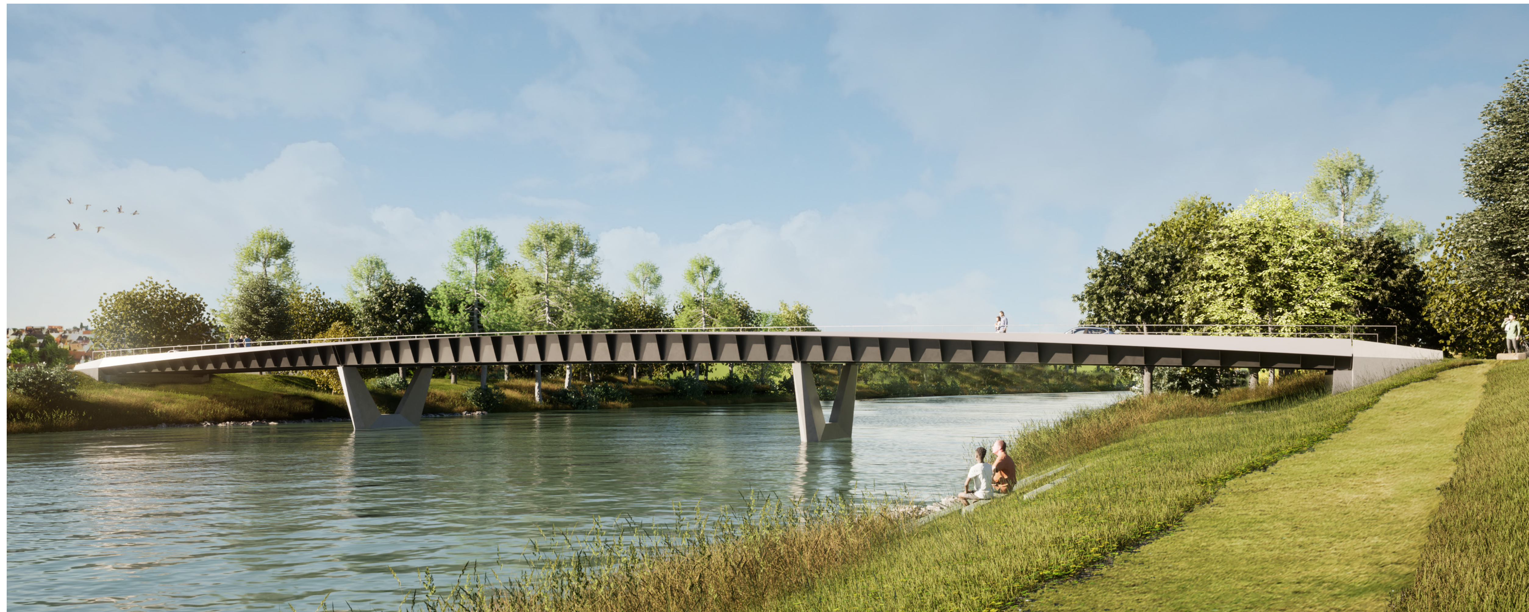
Blick vom südwestlichen Uferbereich
