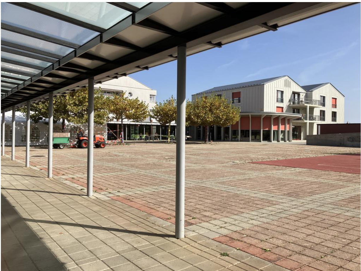
Place centrale du site – Vue sur maisons M15-M16
