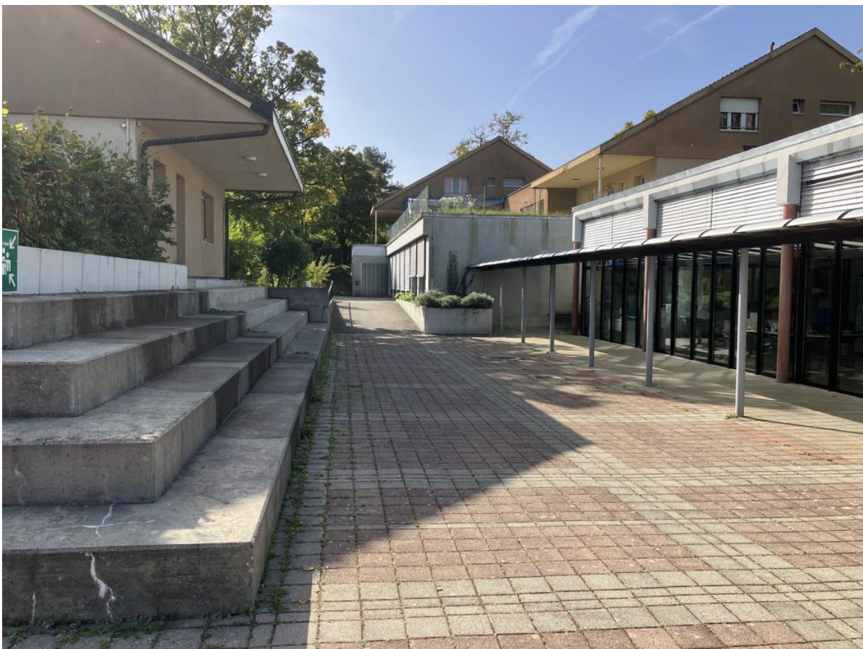
Sortie Ouest de la place centrale du site – Vue sur maisons M5, M3 et M4
