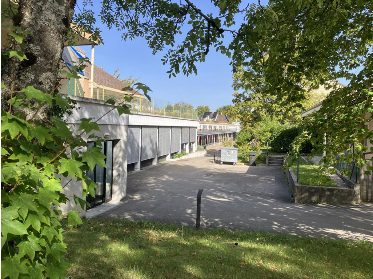
Sortie Ouest de la place centrale du site – Vue (à gauche) sur socle maisons M3 et M4 (à démolir)
