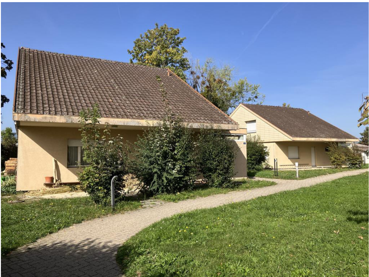
Maisons M2 et M1 (à démolir)
