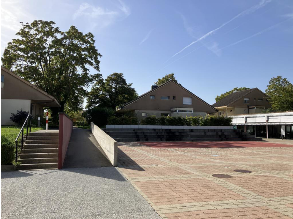
Place centrale du site – Vue sur maisons M7, M5 et-M3
