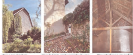
Pignons sans ouvertures
