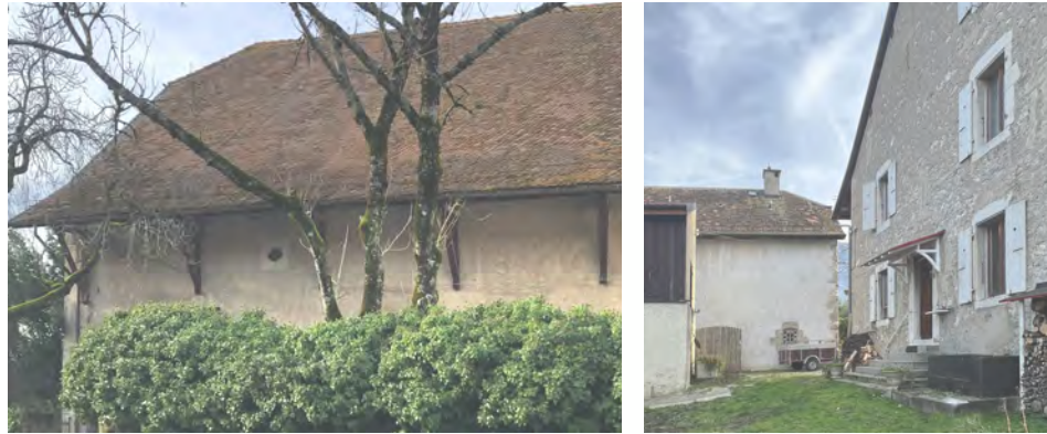
Toiture sans percements, enduits minéraux Différenciation volumétrique, teintes neutres Pignon sans ouvertures Cour de boulets, arasees arrondies des murs Charpente d'origine sous combles
