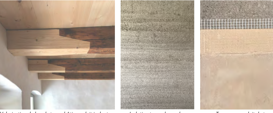
Valorisation de la substance bâtie, enduit isolant Isolation terre-chaux-chanvre Terre crue, enduit de terre Maximisation de l'usage du bois Enduits à la chaux, menuiseries en bois Crépis lavé avec agrégats locaux
