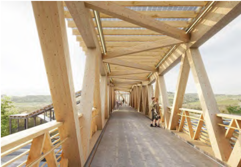
Die Passerelle führt direkt zu den Perrons. Die Lüftungsbauweise ist provisorisch und bedingt.
