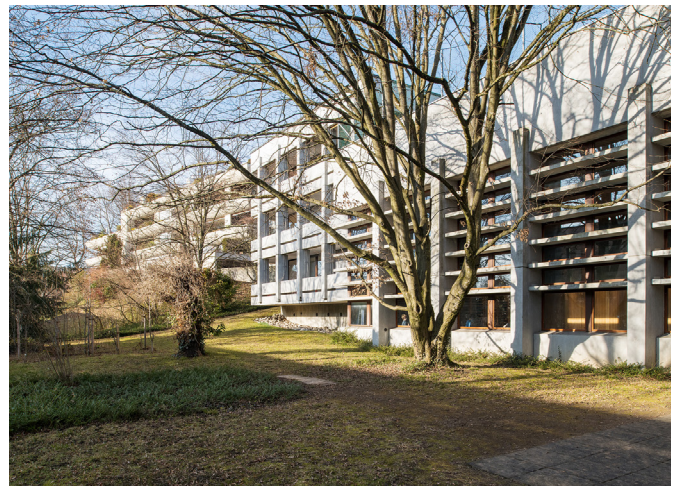
Ansicht Turnhallentrakt und Wohnhaustrakt, 2022, AFS
