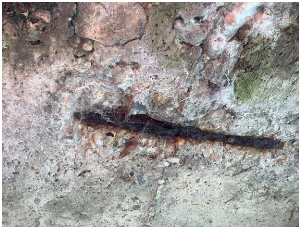
Befund: 2205 Stark gerostete Bewehrung Intrados dalle, sous chaussée, sorties de chaque côté, 3 zones de 250 cm 2
