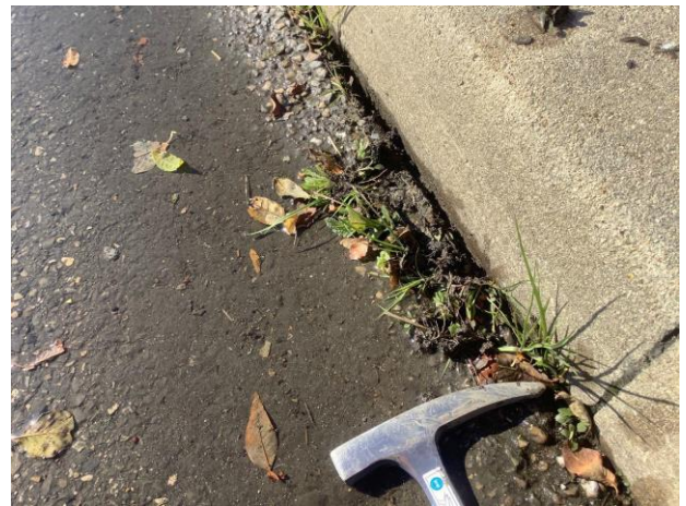
Befund: 317 Undichte Randabschlüsse Contre bordures trottoir , Couverture de végétation
