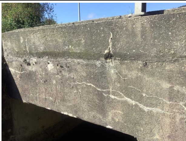
Befund: 1210 Längsrisse Mur d'a et parapet
