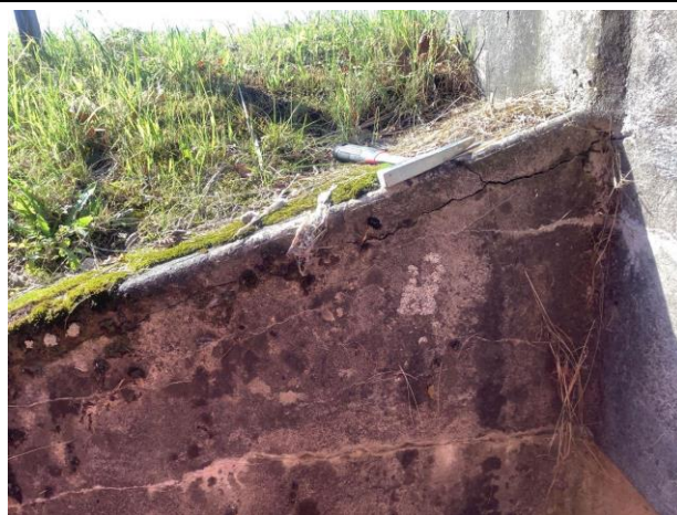
Befund: 1210 Längsrisse Mur d'a et parapet
