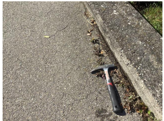
Befund: 317 Undichte Randabschlüsse Bordure béton , Couverture de végétation
