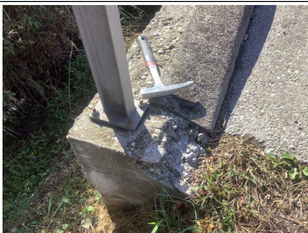
Befund: 1303 Abplatzungen Côté Bienne , Gel
