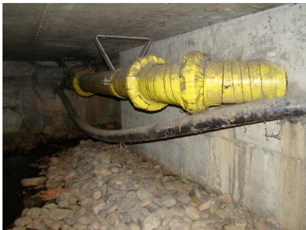
Befund: \ anderer Befund Conduite PE encombre le passage de l'eau. A fixer.
