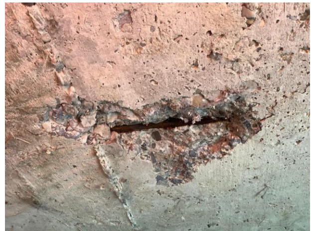
Befund: 2205 Stark gerostete Bewehrung Intrados dalle, sous chaussée, sorties de chaque côté, 3 zones de 250 cm 2
