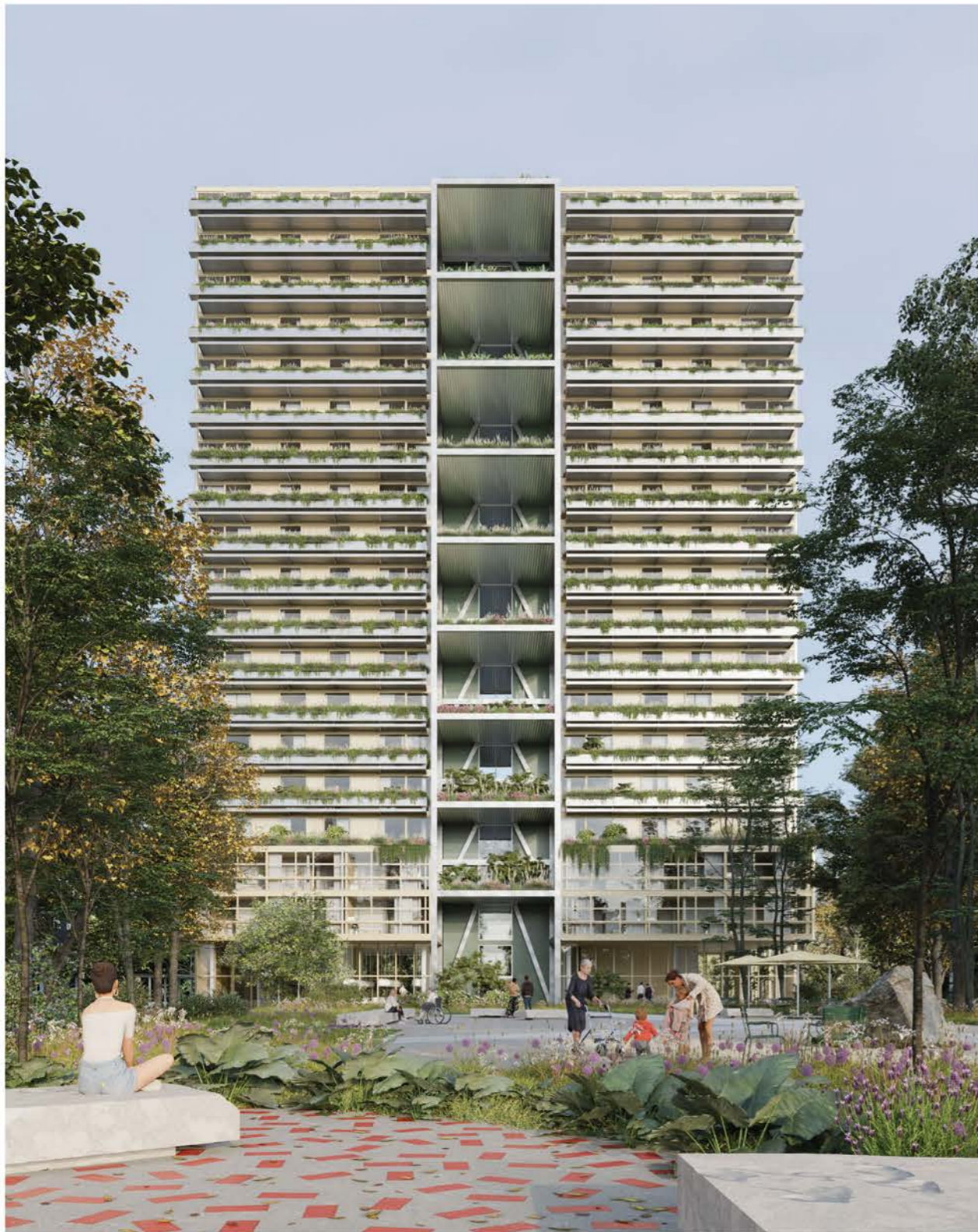
Oase Winterthur im Park Sulzerallee
