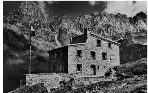
Abb. Neue Hütte 1960 Südwestseite
