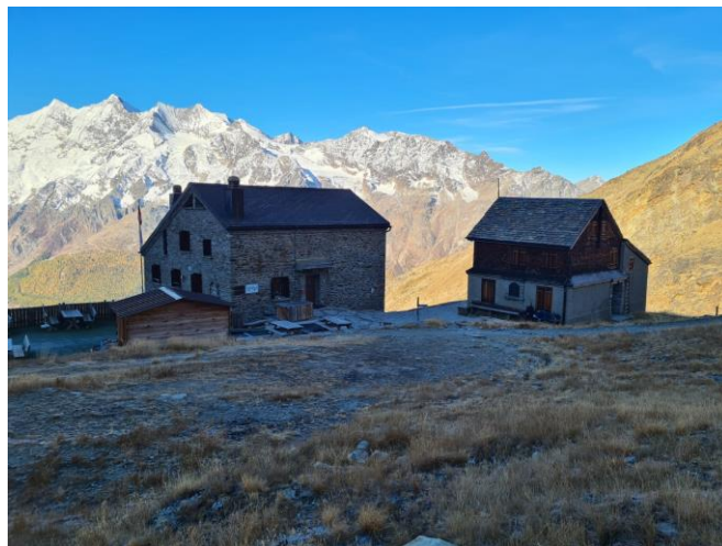
Abb. Hütten heute nordostseitig
