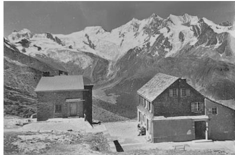
Abb. Links neue Hütte 1960, rechts alte Hütte saniert
